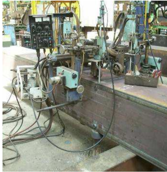
Electro slag welding
